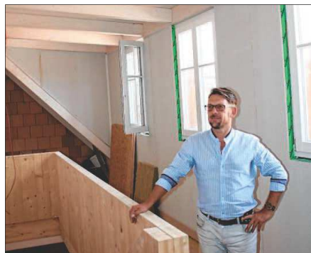
Planer Arnold Schmid zeigte bei einem Rundgang den Baufortschritt auf und gab einige Informationen zum Projekt.
