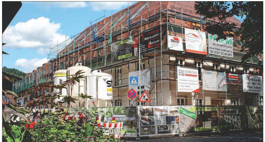
Keine Handwerkerferien: Am »Stadthotel Hansjakob« am Eingang der Haslacher Altstadt wird kräftig gearbeitet, damit das Hotel wie geplant am 1. März 2020 eröffnet werden kann. Fotos: Reinhold Heppner
